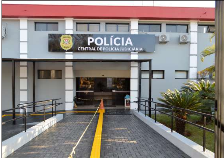
Fachada da Central de Polícia Judiciária, na Estação, após pintura
