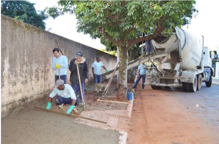
Calçadas estão sendo recuperadas
